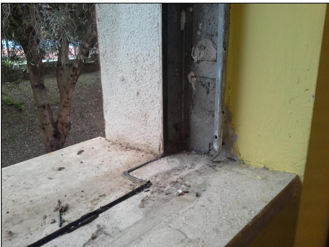
**Figura 6 - Particolare del controtelaio in essere**
