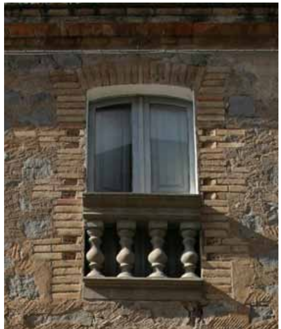
02. aperture con piattabanda e stipiti in mattoni cotti
