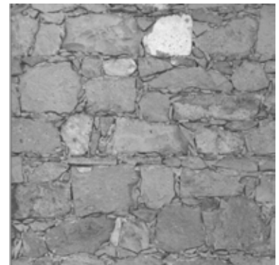
muratura con elementi in pietra di Serrenti grossolanamente sbazzati
