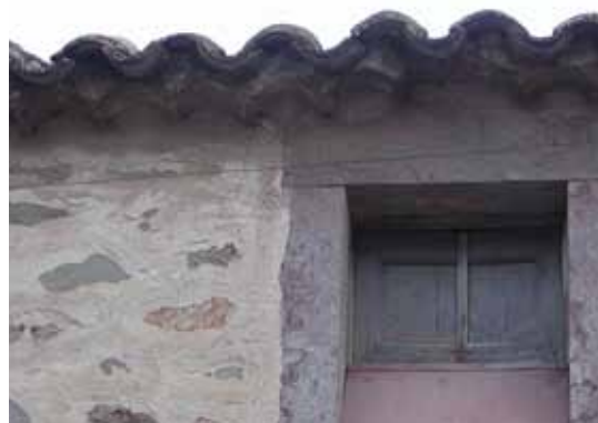
02. aggetto con cornice realizzata con una fila di tegole convesse
