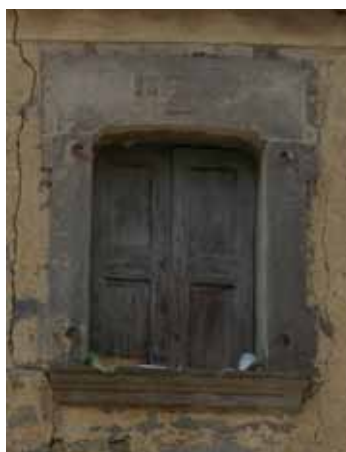
Finestre a due ante con scuretto interno
