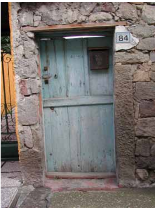
01. aperture con architrave lignea
