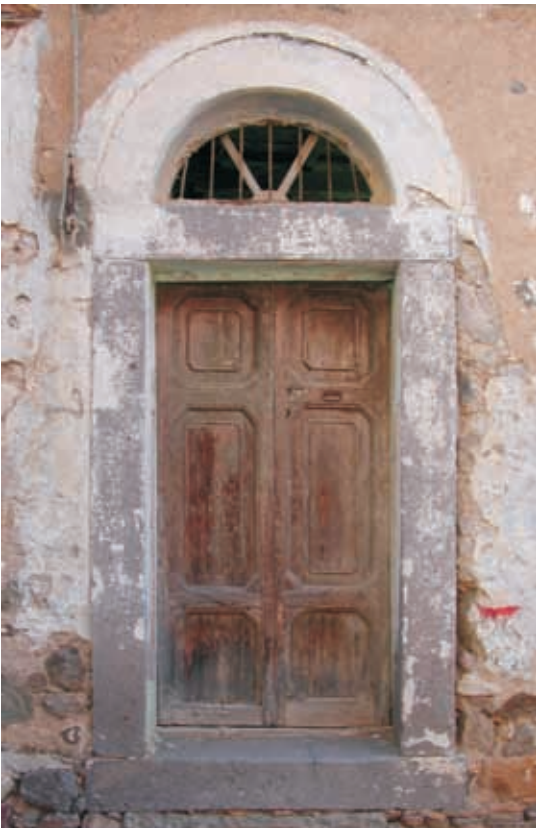
03. aperture con architrave e stipiti in pietra di Serrenti lavorata
