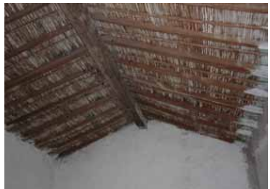
02. copertura a falda doppia (corpo semplice)
