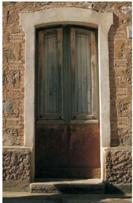
04. aperture con piattabanda e stipiti intonacati
