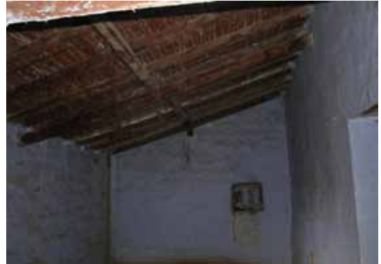
01. copertura a falda unica (corpo semplice)
